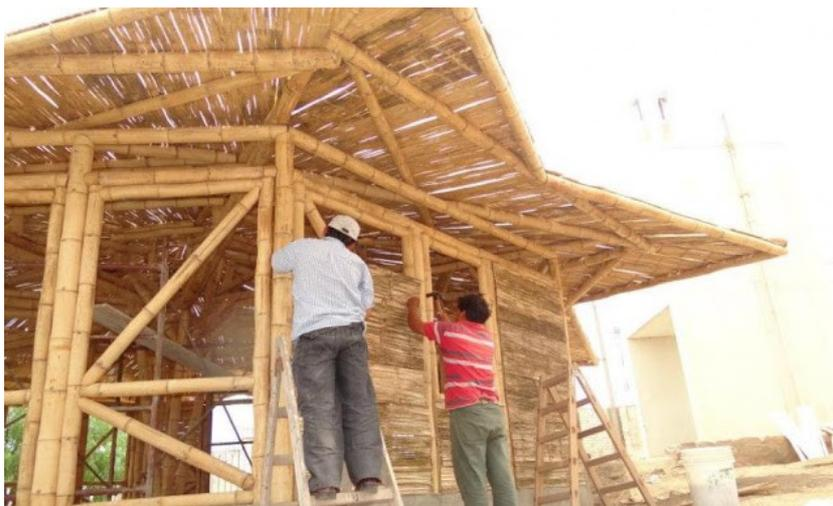
la caña guagua es un material maravilloso que bien se ha usado en el mundo entero, pero no por serlo es ya una panacea constructiva. De igual manera que todo material que es usado incorrectamente, si no se construye con la debida estabilidad por triángulos, también puede convertirse en un elemento de catástrofe.
